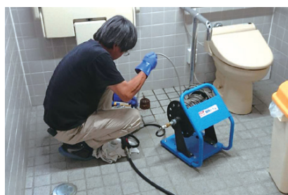
悪臭の原因をつきとめて高圧洗浄
