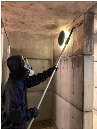
プール施設のカビ取り作業
