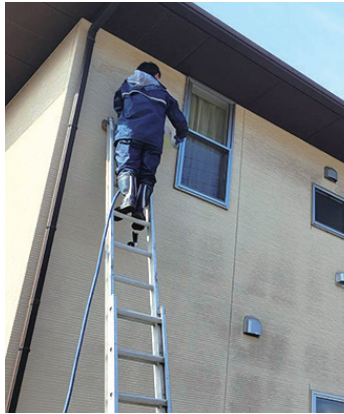
民家外壁のカビ取り作業
