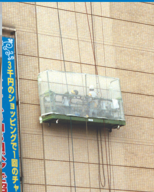
甲府駅ビル外壁清掃
