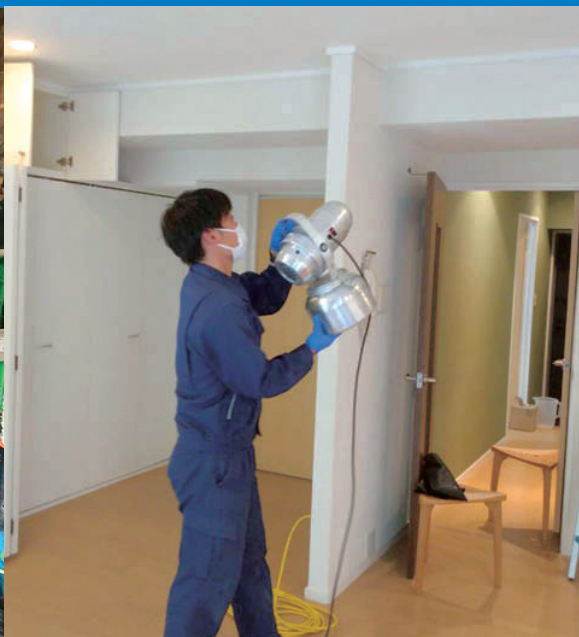
カビ除去作業
